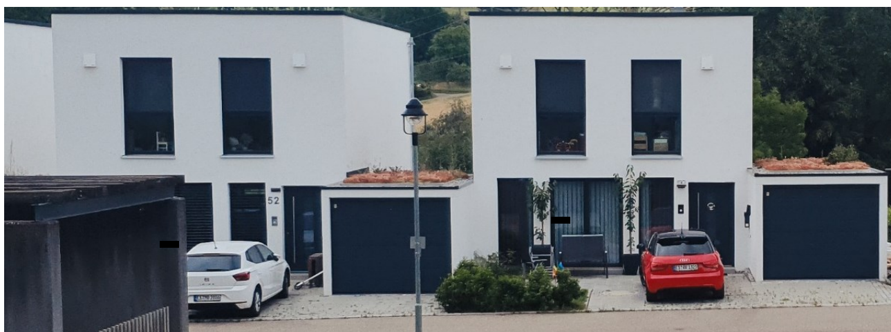
Abbildung 10: Beispielfoto (Esslingen) Gebäude Typ B im WA 2 – Kettenhaus 7 m (KE)
